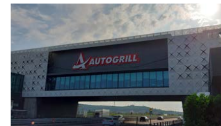
Scaligera Est km 301,6
